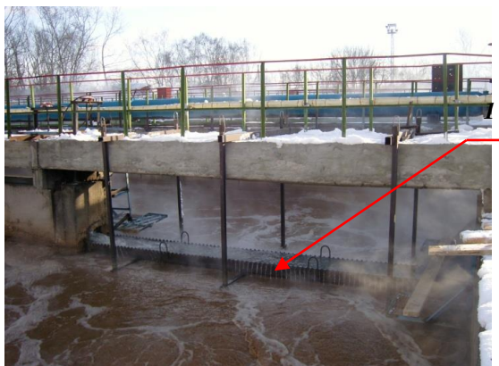
Рис. 1. Фото аэротенка с реконструированной равномерно-рассредоточенной подачей производственных СВ и АИ. 1 – рассеиватели (лотки с перфорацией) СВ и АИ
