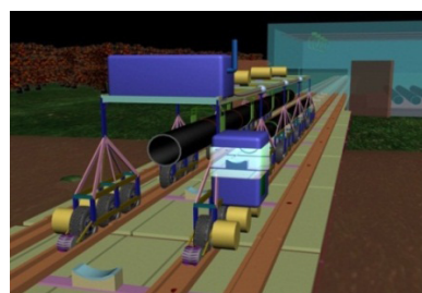
Рис. 3. Укладка трубопровода с помощью автоматизированного трубоукладчика
