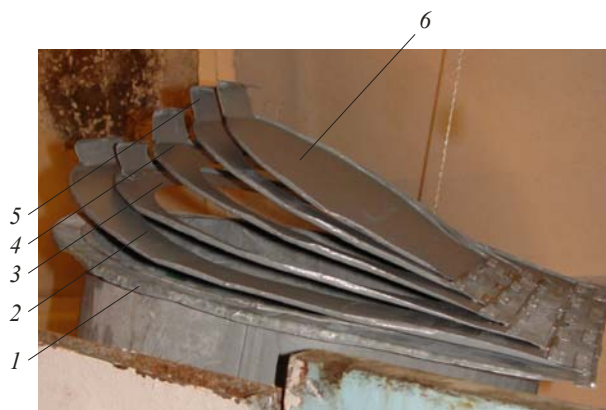
Рис. 3. Фото (вид снизу) расположения заслонок на пять равновеликих площадок у всасывающего отверстия вентилятора: 1 – всасывающий трубопровод, 2-5 – первая, вторая, третья и четвертая заслонка, 6 – крышка
